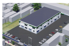
加工新工場：建設予定
